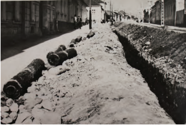
Figura 29. Str. Avram Iancu, conducte de aducțiune a apei, din lemn (fotografie de arhivă) / Avram Iancu Street, wooden water supply pipes (archive photo).
